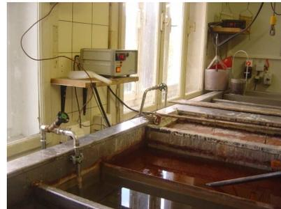
Raccordements de bains galvaniques sans clapets ni disconnecteurs
